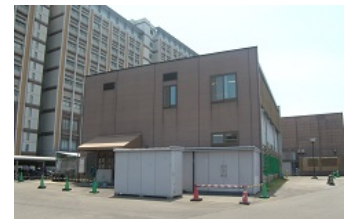
写真1 エコセンター
