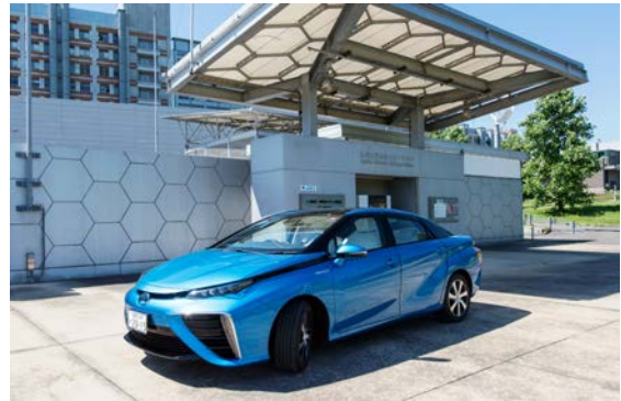
水素ステーション
